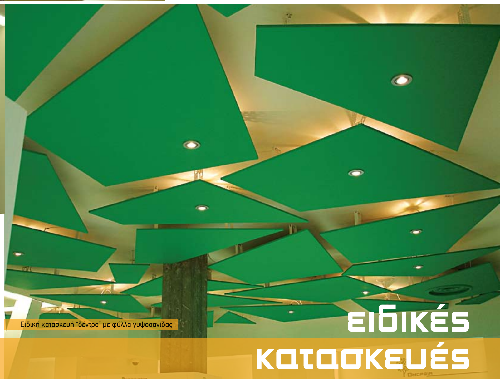
Περίτεχνη κατασκευή από γυψοσανίδα με κρυφό φωτισμό
